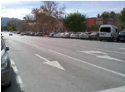
Avda. Pio Baroja (Zona implantación nuevo pavimento)
