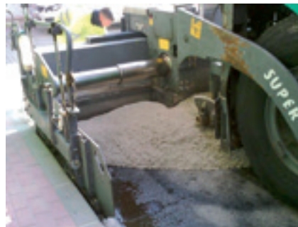
Segunda prueba industrial, extendido asfalto (Murcia)
