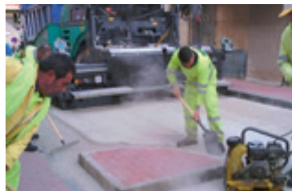
Segunda prueba industrial, extendido asfalto (Murcia)
